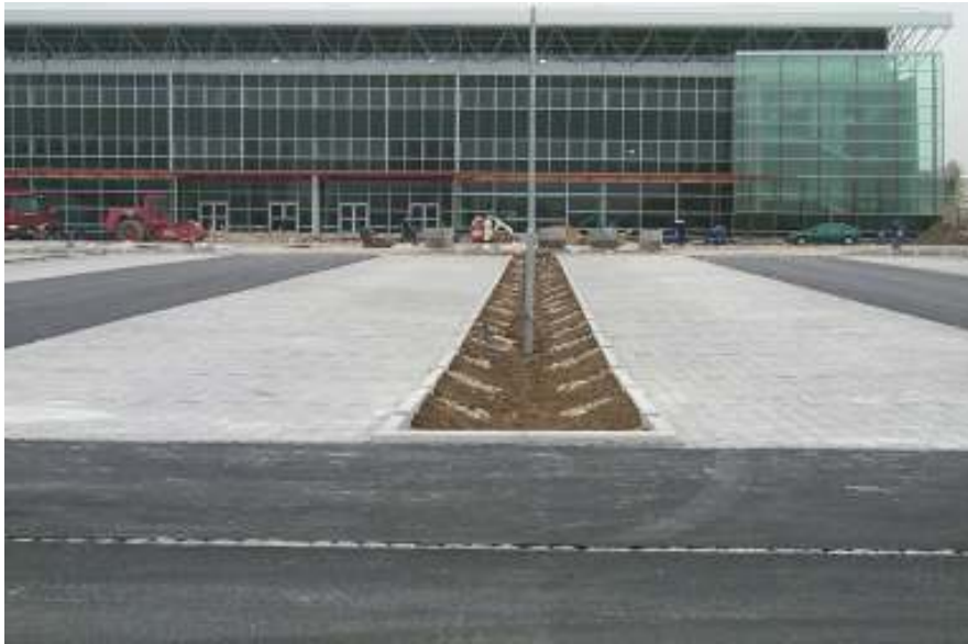
Parkirišče v gradnji v 2003.
