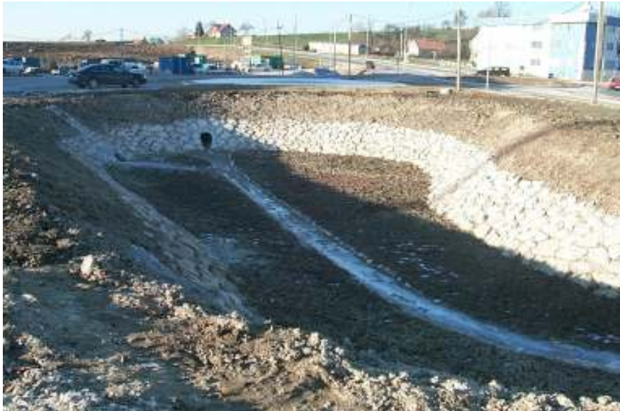
Zemeljski zadrževalni bazen v gradnji v 2003.
